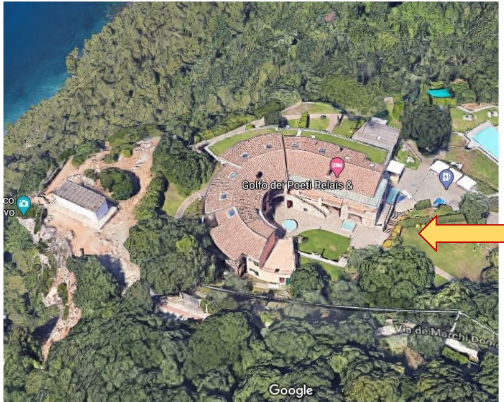
VISTA AEREA EST
