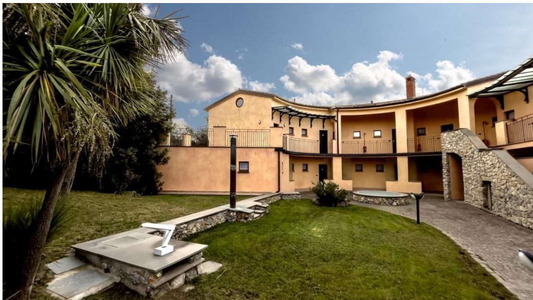
VISTA DAL CORTILE INTERNO
